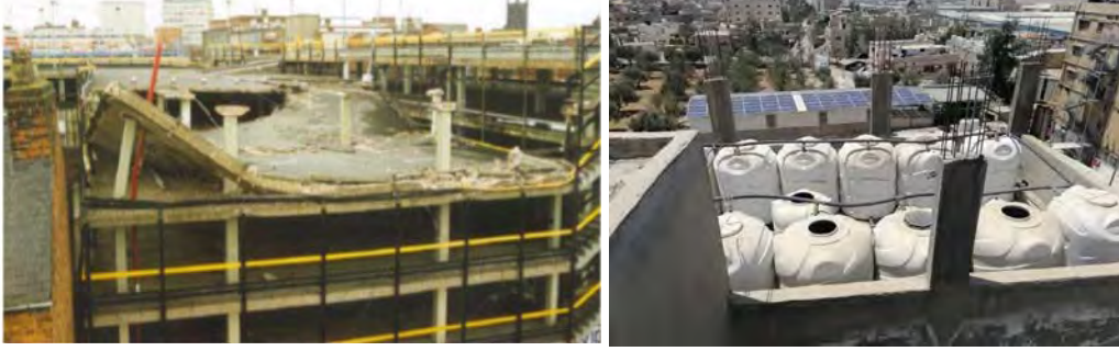
الشكل 5-7: التحميل الزائد على بلاطات الاسطح واحتمالية الانهيار
