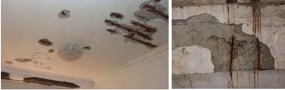
الشكل 2-7: تآكل حديد التسليح بسبب فقدان الغطاء الخرساني
